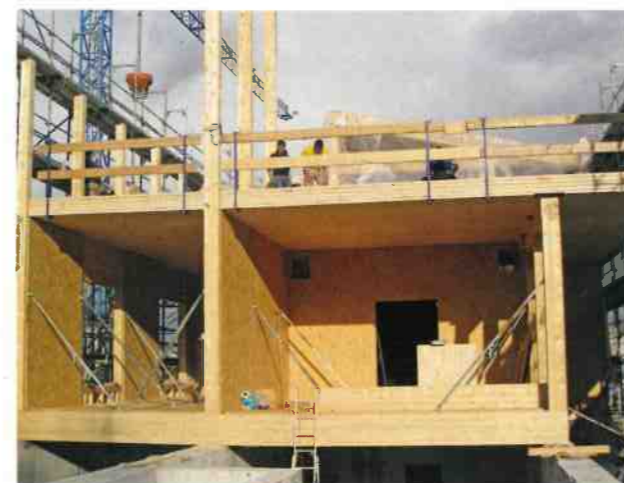
Struttura zona entrate con soletta massiccia in XLAM
