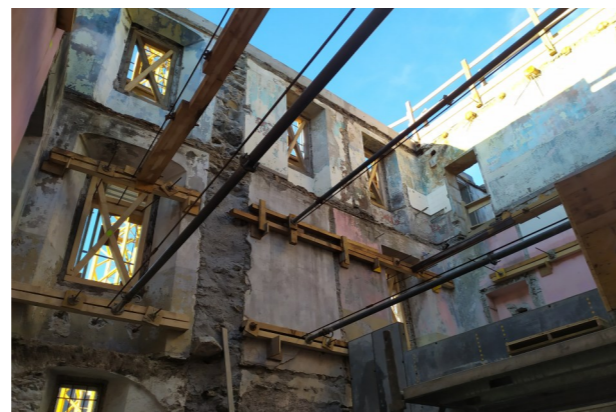
Demolizioni solette esistenti e puntellazioni
