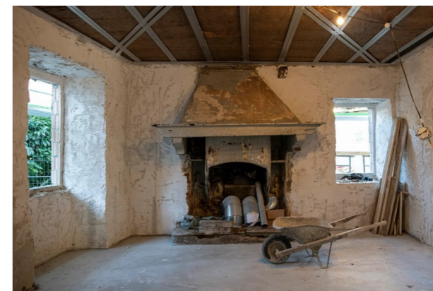
Nuovo solaio in costruzione leggera Cocoon-Knauf
