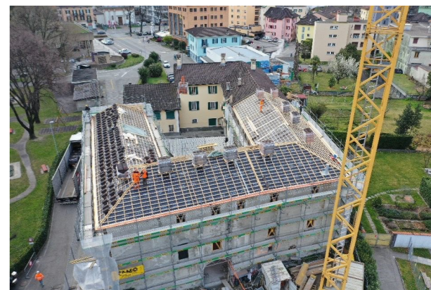
Vista aerea formazione nuovo tetto
